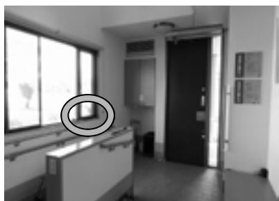
図 2 玄関（窓際等にタグ設置）
