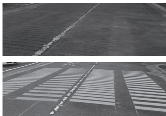
図1 試験施工した路面
