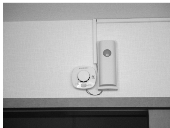
図1 壁面取り付け例 Fig.1 Wall mounting cases
