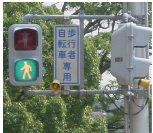
図24 同一柱に2方向のスピーカを取り付けた例
