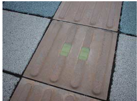
図3 事例3 - 蓄光材入り誘導用ブロック Fig.3 Case3-Light accumulating studded paving block
