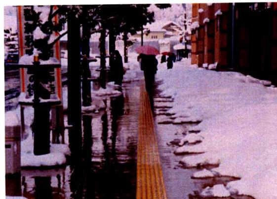
写真2 歩道上の散水消雪施設稼動状況
