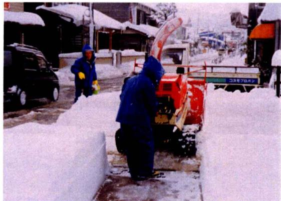
写真7 ハンドガイド式小型除雪機による歩道除雪状況（香住町内県道）
