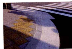
写真2 試験施工箇所2
