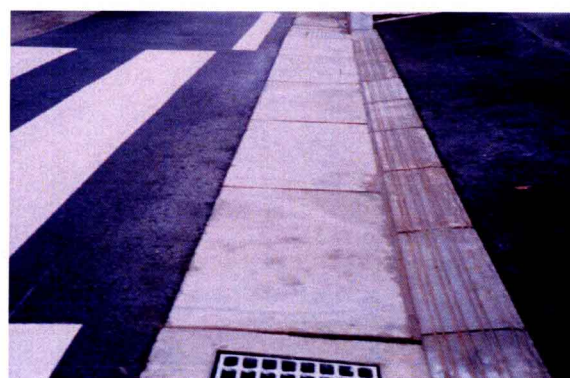
写真19 望ましい段差構造最終形による試験施工箇所（兵庫県高砂市米田町地先） Pic.19 Place of test construction by the ultimate standard form (in Takasago City)
