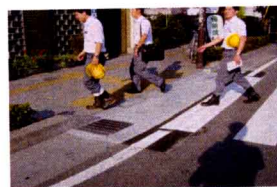
写真1 試験施工箇所1
