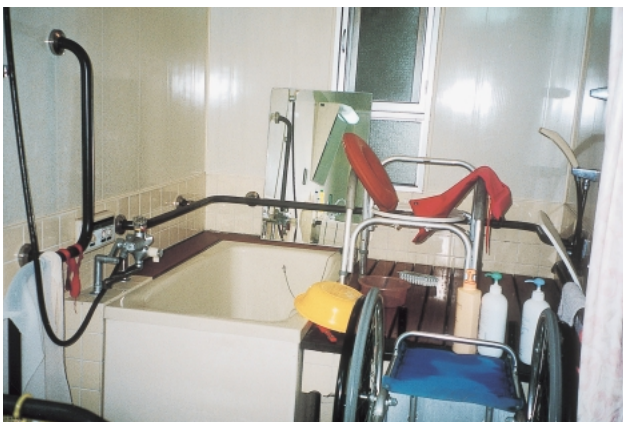
写真6：取り外せない洗い台 (入居者は造り付けの洗い台には移乗できない。このため、操作性のよい洗い台横のシャワーは使用できない。)
