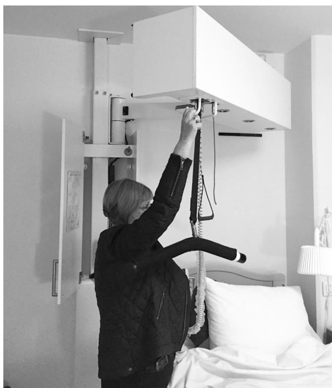
図2 National Display Apartmentに設置されている枕元のキャビネットに納められたリフター
