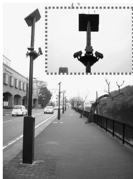
図3 設置されたLED照明
