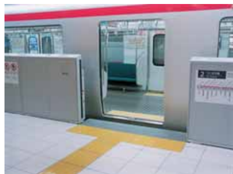
写真2 可動柵と車両乗車口の滑り止め
