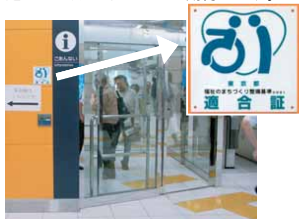
写真3 駅員室入口に貼られた適合証
