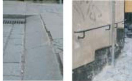
写真2 石の段差解消（左）と外壁手すり（右）
