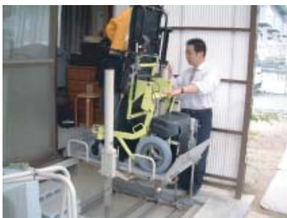
写真7 段差解消機を使って出入り
