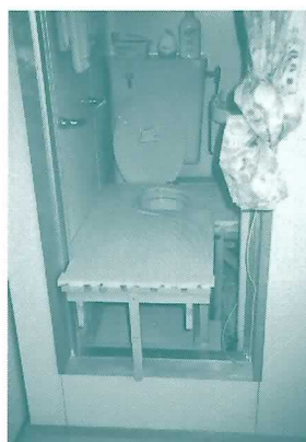
図2-c 補高台の上に バスマットを設置
