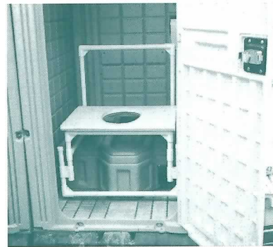
写真1 仮設トイレの椅子
