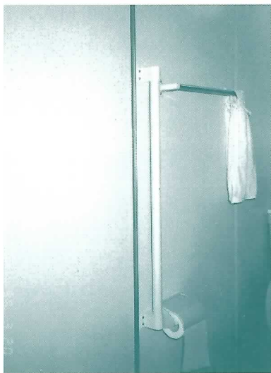
写真4 トイレの手すり
