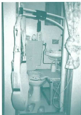
図3-a 入浴介護用リフトの設置
