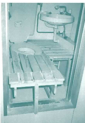
図2-b 補高台の設置
