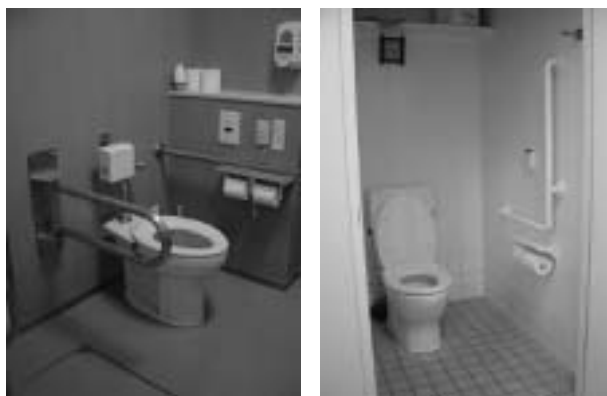
図39 トイレ内部・金融機関/コンビニエンスストア Fig.39 Bank's and convenience-store's toilets
