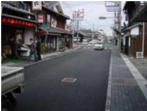
図 17 . 歩車分離された段差のない道路 Fig.17 Flat street with sidewalk for pedestrians
