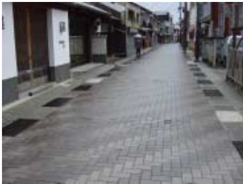
図 11 全面的に敷設されたインターロッキング Fig.11 Interlocked tiles covering a whole street
