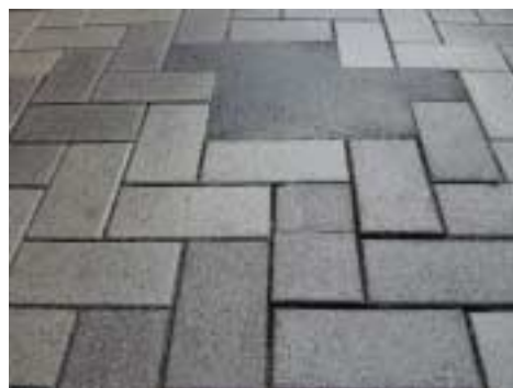
図 10 . インターロッキングの凹凸 Fig.10 Bumpy street with interlocked tiles
