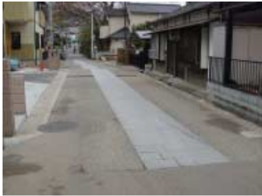
図 16 . 道路中央にデザインされた石張り Fig.16 Stones covering the center of a street
