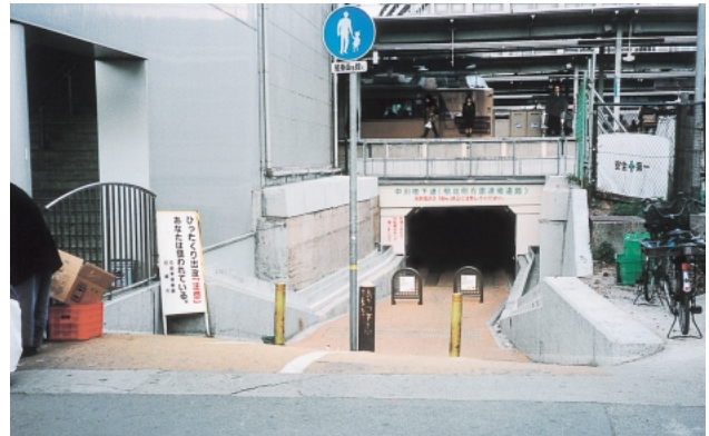
図3 駅の近くにある地下道の出入口の事例
