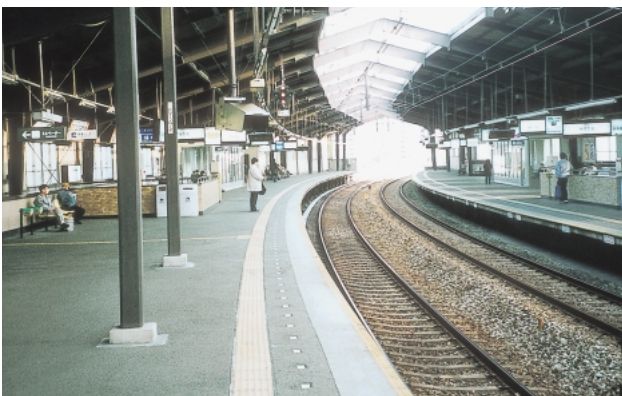
図6 ホームがカーブしているために車両とのすき間が大きくなると考えられる事例
